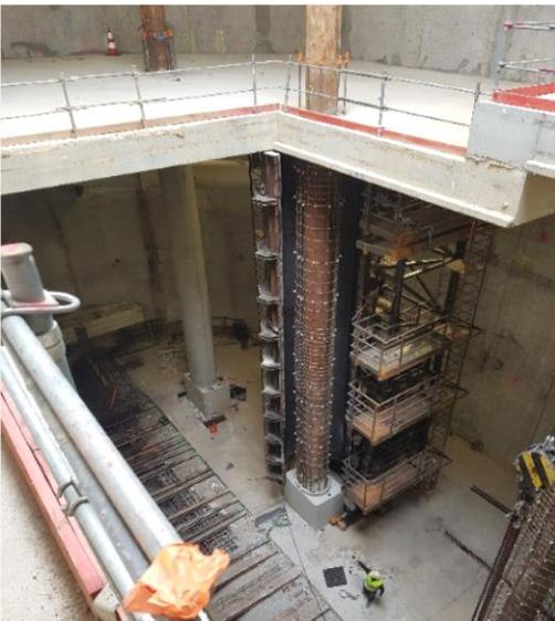
A Oullins, la station disposera également de 3 niveaux : -1 (salle des billets), -2 (mezzanine), -3 (quais). **Les derniers mois ont permis d'achever la dalle de la salle des billets et d'atteindre le fond de la station, situé à 28 m.** Les compagnons poursuivent leur travail sous la dalle de couverture pour l'arrivée prochaine du tunnelier.
